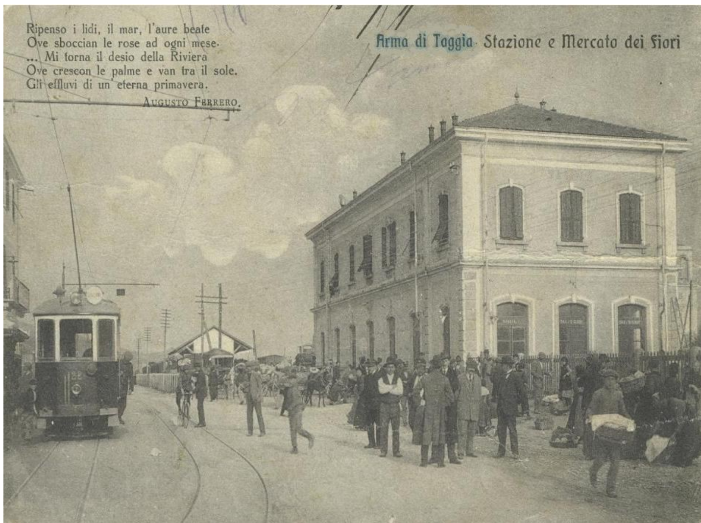
La Stazione ferroviaria di Arma di Taggia con il I° mercato dei fiori della Liguria - Al centro, sullo sfondo, "La Piccola", la stazione dove avveniva lo stoccaggio, arrivo e partenza delle merci
